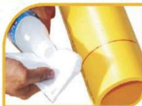
Raspas el final del tubo por la parte externa hasta una distancia igual a la (longitud de la unión)/2 + 10 mm.
